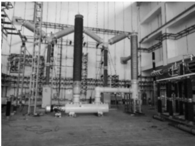
图 16 断路器开断试验 Fig. 16 Switching test of circuit breaker
